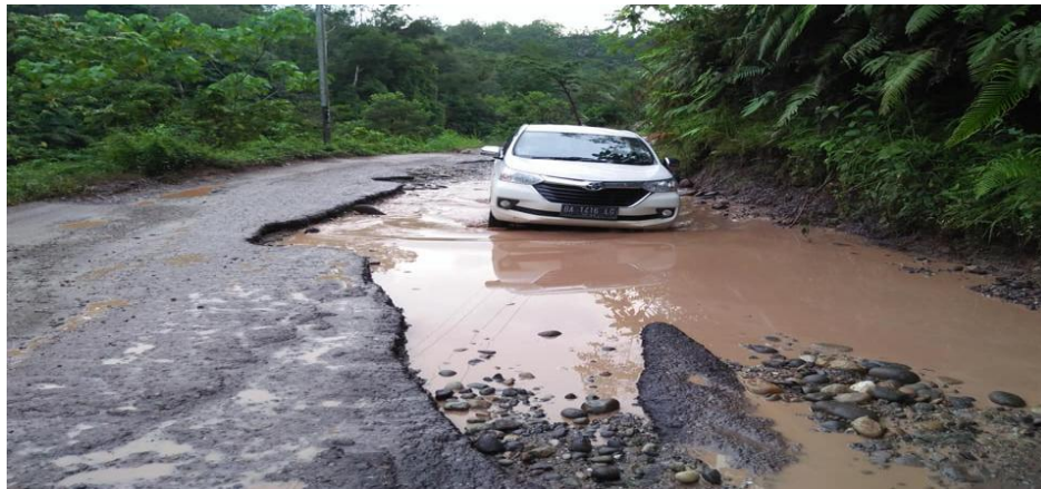
Gambar 1. Kerusakan jalan akibat sering dilalui kendaraan yang bernomor Polisi Luar Daerah
